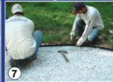
Install Edge Restraint
